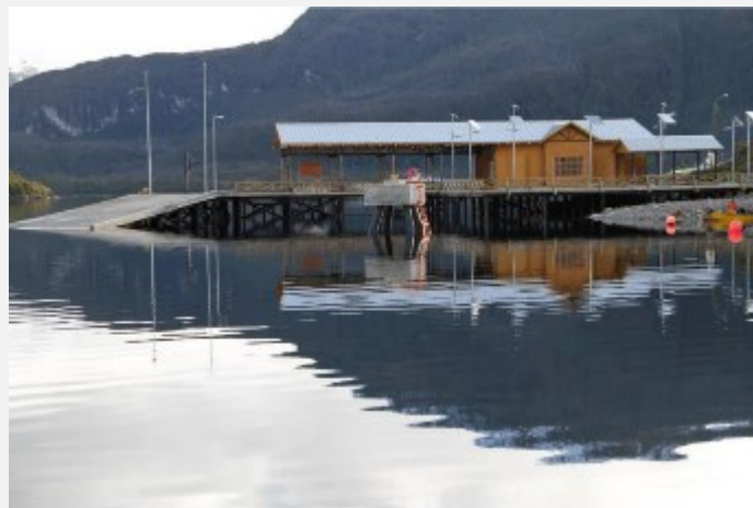
Figura: Rampa y Refugio DOP-MOP
