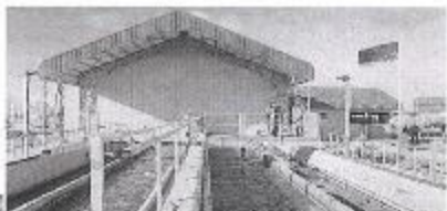
La planta de tratamiento de aguas residuales de Puerto Natales recibió una importante inversión para ser ampliada.
