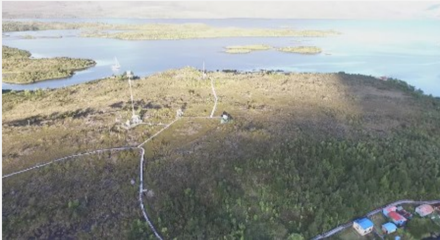
Figura: Ubicación antena ENTEL S.A.
