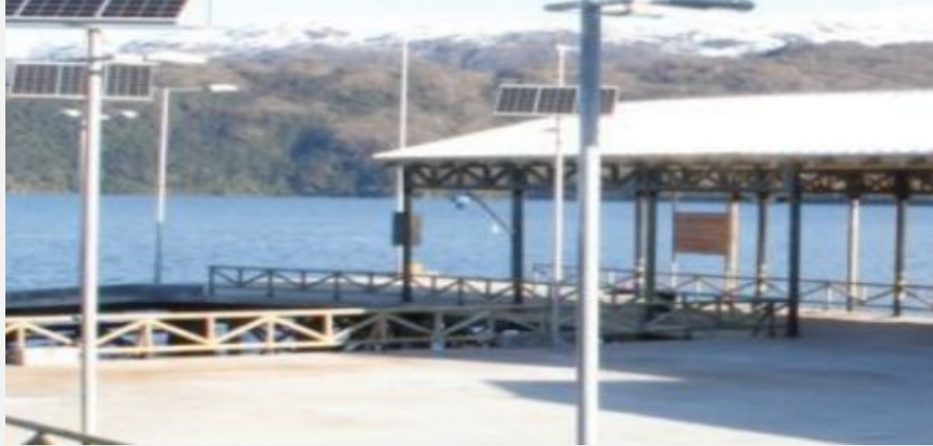
Figura: Explanada de Rampa y Refugio DOP-MOP
