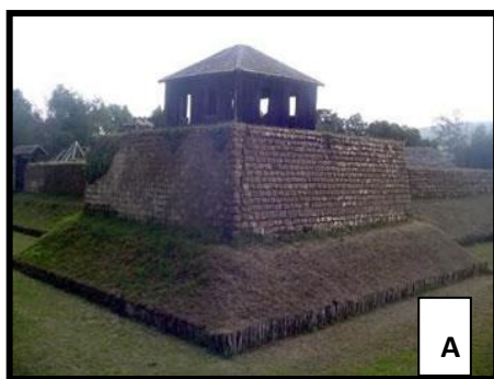
Figuras 11 y 12. Fortificaciones del siglo XVII construidas con piedra cancagua
