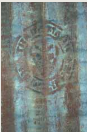
(87). Fotografía de un sello estampado en las planchas de zinc originales de la Casa Stirling Seal stamped on the Casa Stirling's original zinc siding
