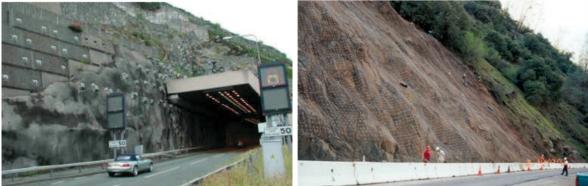
Figura 71. Estabilización mediante shotcrete, mallas y anclajes más berma de protección
