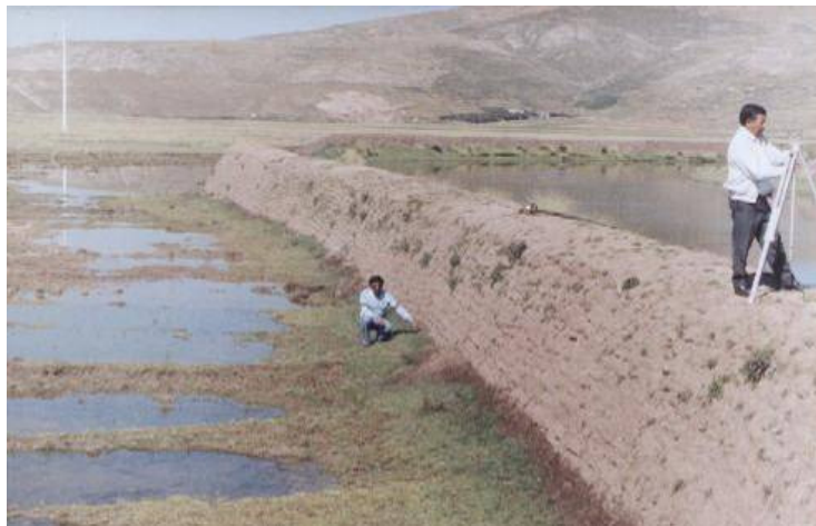
Figura 58: Fotografía de protección con dique
