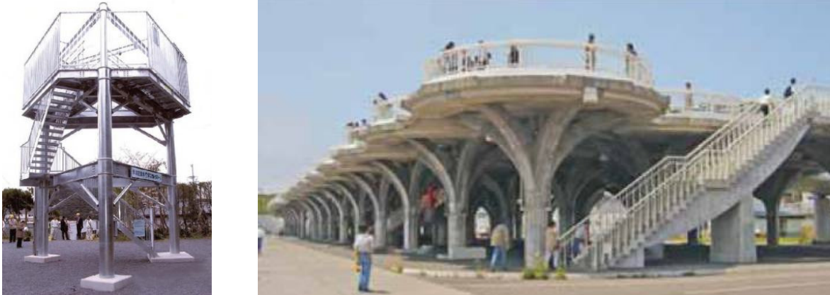
Figura 97. Torres de evacuación de tsunami, Japón.
