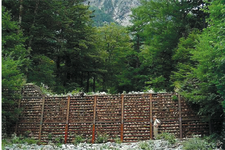
Figura 73. Muro de contención para flujos de detritos
