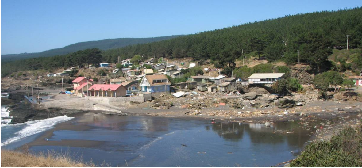
Figura 43. Fotografía de muro de contención de caleta de Pellines.
