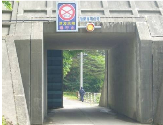
Figura 48. Compuerta de mitigación para Tsunami en la ciudad de Miyako y Hiro, Japón.
