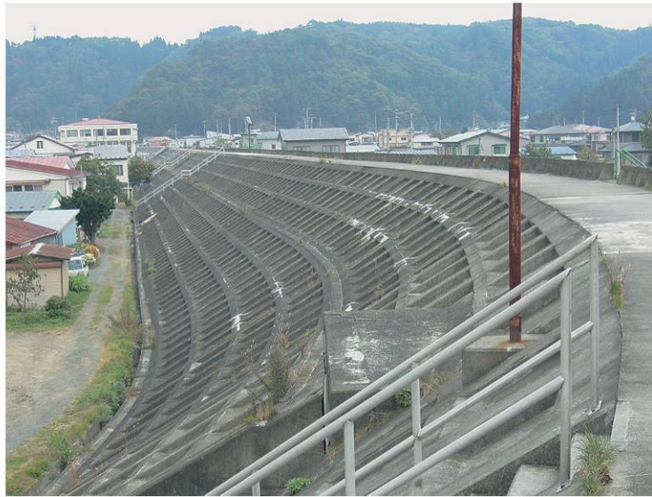
Figura 41. Muro de defensa costera contra tsunami en Taro
