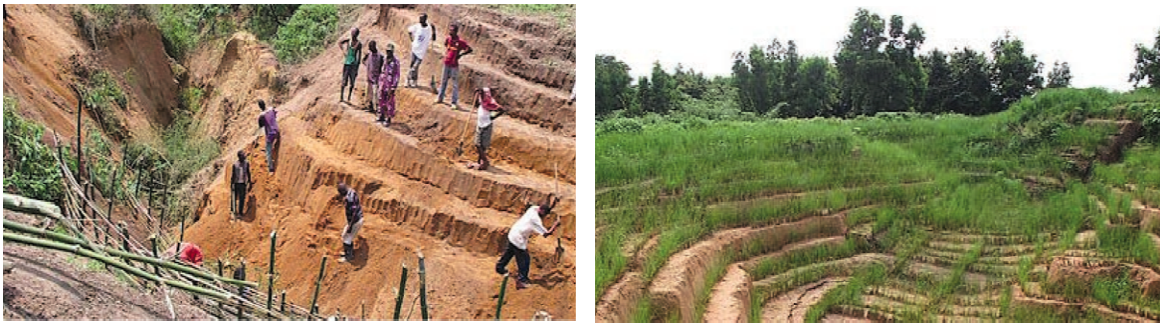
Figura 75. Estabilización mediante sistema biotécnico
