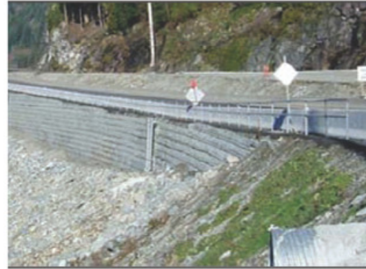
Figura 70. Estabilización mediante refuerzo de las pendientes
