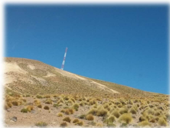
Imagen N° 11 Antenas Telefónicas Comuna De Huara - Chiapa
