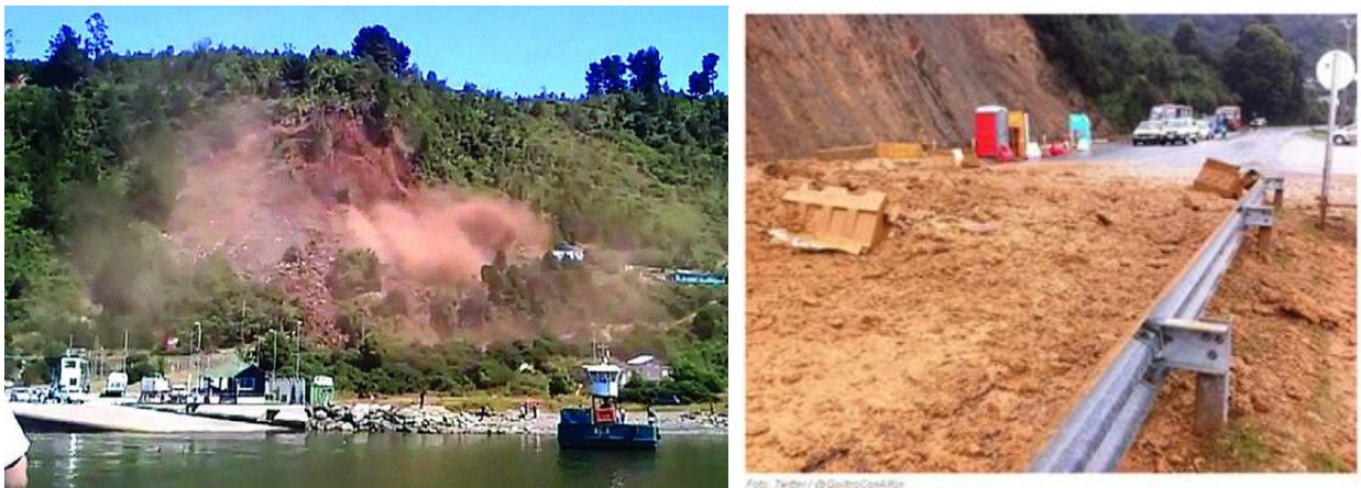
Fotografías N° 3 y 4. Efectos deslizamiento y caída de rocas, 16 de enero 2013 y 28 de mayo 2013.
