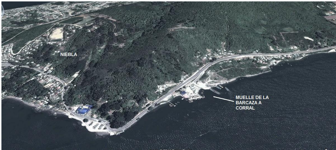
Figura N° 61. Zona portuaria de Niebla. Fuente: LPT-UCT 2014
