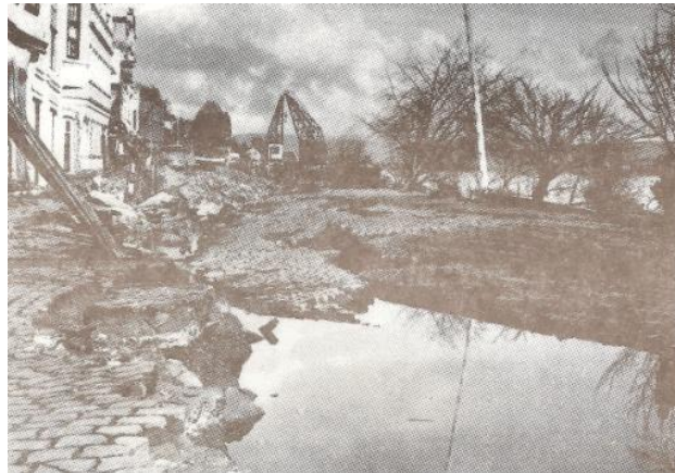
Fotografía N°2. Destrucción de viviendas por efecto del Terremoto 1960 en la ciudad de Valdivia. Fuente: Diario Austral de Valdivia, Mayo 1960.
