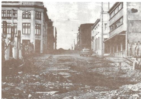
Fotografía N°1. Destrucción de viviendas por efecto del terremoto 1960 en la ciudad de Valdivia. Fuente Diario Austral de Valdivia, Mayo 1960.
