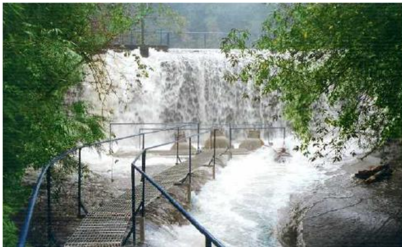
Fotografía N°22. Planta de Tratamiento de Llancahue. Fuente: Aguas Décima.
