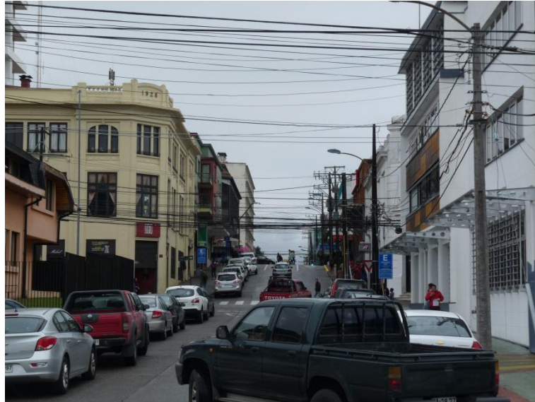
Fotografía N° 9. Imagen en que se aprecian los tendidos eléctricos (más altos y gruesos) y los tendidos telefónicos y de alumbrado, todos aéreos. Fuente: LPT-UCT 2014
