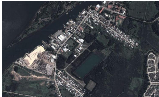
Fotografía N° 18. Localización de balsa de alivio o rebalsamiento en Las Mulatas. Fuente: Google Earth, 2013.
