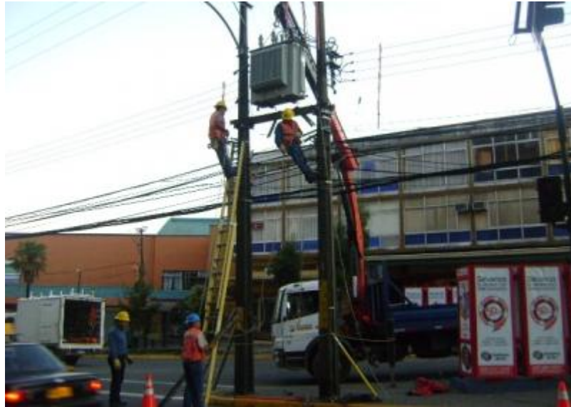
Fotografía N° 19. Instalación de un Centro de Transformación, Valdivia. Fuente: www.elnavegable.cl ; 2014.
